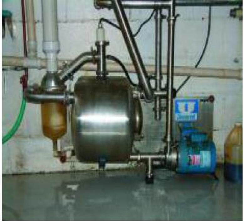
شكل مضخة التفريغ مع مقياس مستوى تخلخل الضغط
