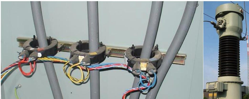
محول تيار يستخدم كجهاز قياس لمصدر تيار ثلاثي الأوجه ٤٠٠ أمبير
